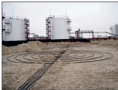
Рис. 10. Горизонтальные охлаждающие элементы в основание емкостей резервуарного парка (фото «Фундаментстройаркос»)
