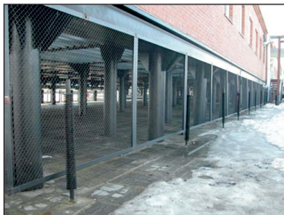
Рис. 9. Скважинные охлаждающие элементы на сооружениях Юбилейного месторождения (фото «Фундаментстройаркос»)
